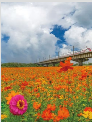
下淡水溪鐵橋 拍攝地點：屏東縣屏東市 拍攝者：陳良印醫師
